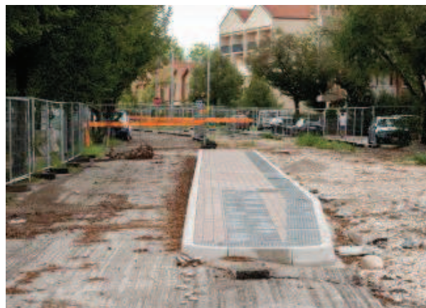
Uno dei cantieri per la filovia rimasti aperti, in via Caperle
